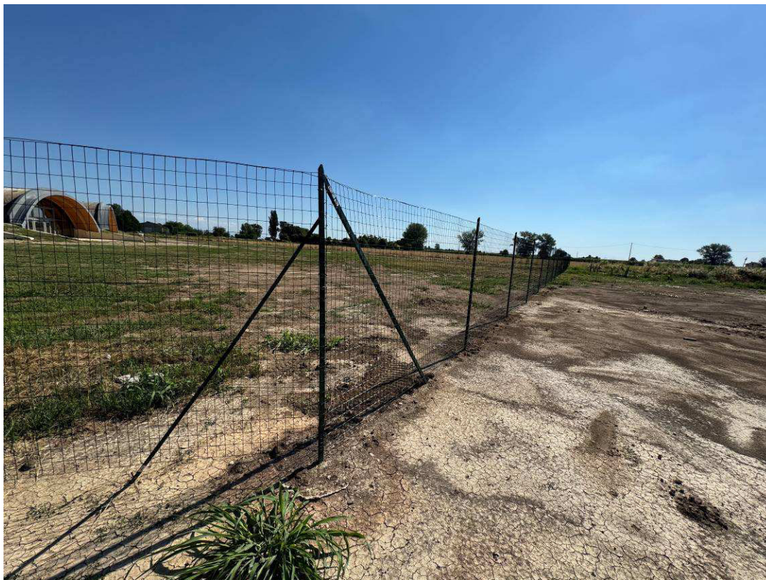
Foto 11 Recinzione scuola a confine con nuovo parcheggio su Via Berlinguer
