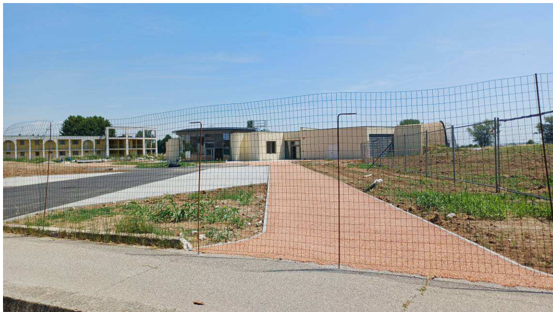
Foto 1 Panoramica ingresso principale (Lotto 1)
