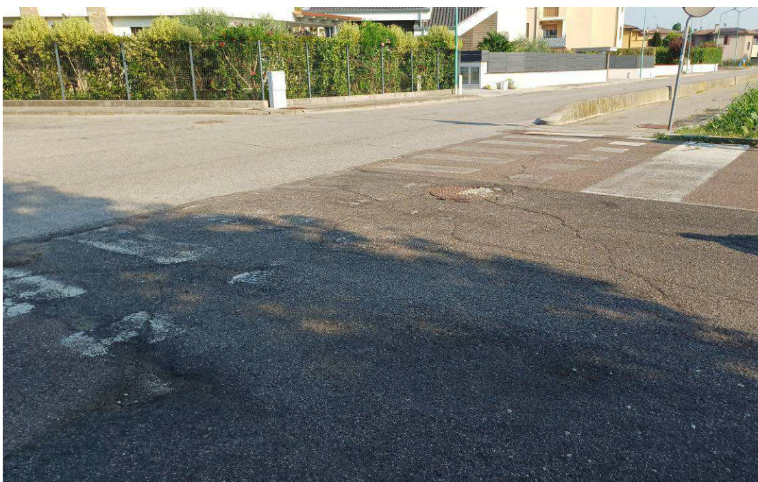
Foto 22 Pozzetto per collegamen to acque meteoriche parcheggio 3 Via Berlinguer
