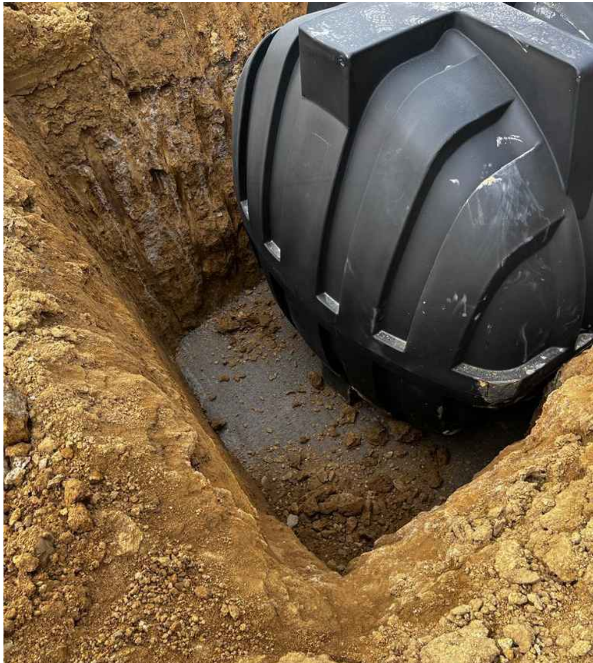
Esempio di posa di sistema di accumulo e riutilizzo acque meteoriche - tipo IRRIGUA PLUS 3500
