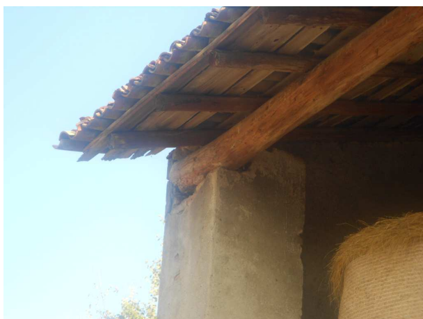
3. Particolare di collegamento copertura-pilastro
