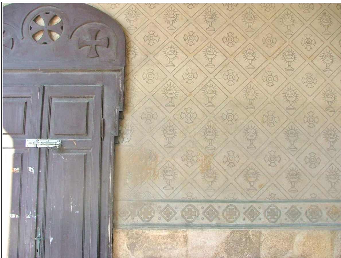
Figura 13 – Vista della finitura ad intonaco con decorazioni ad incisione delle murature longitudinali della campata centrale della ex – chiesetta del cimitero di S. Maddalena
