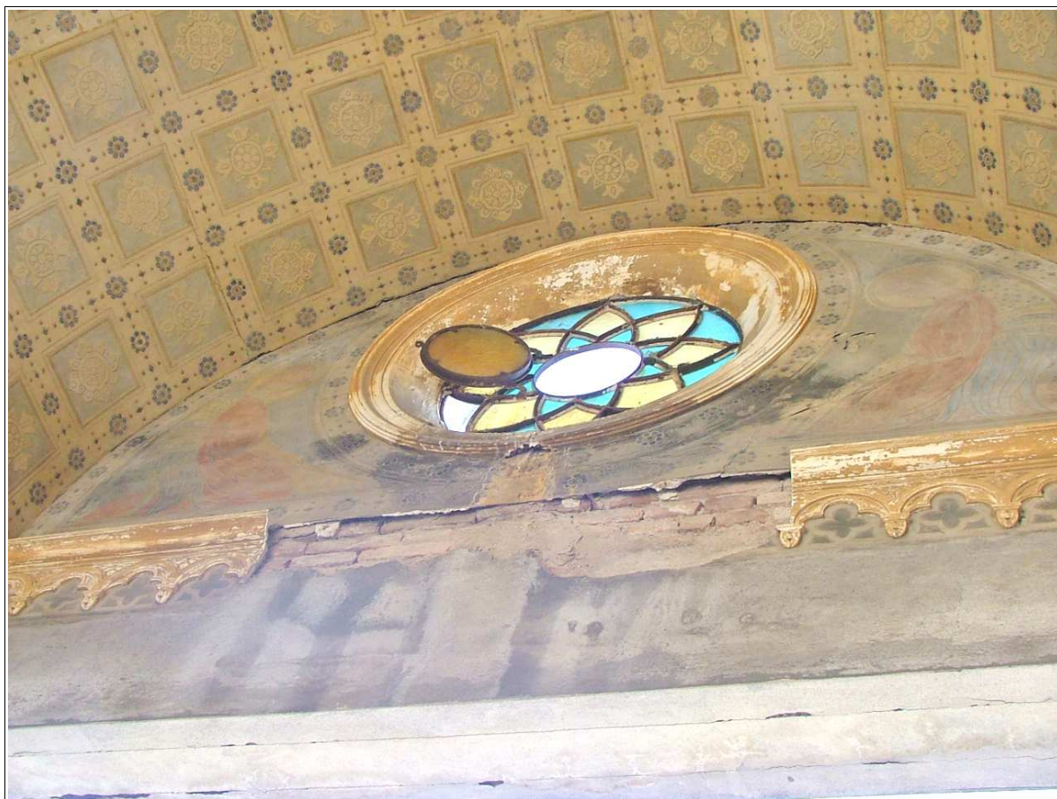
Figura 14 – Porzione di fregio mancante sul fronte ad est della loggia
