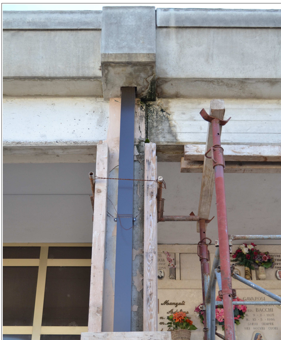
Figura 20 – Lesione in corrispondenza del giunto di fabbrica tra i corpi del 1992 e del 1995
