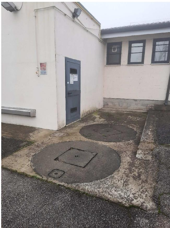
VISTA 32 – POZZETTI TIPO IMHOFF – IMPIANTO TRATTAMENTO ACQUE REFLUE
