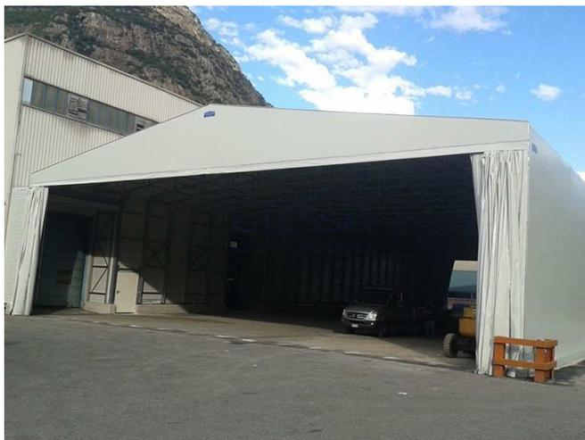
Fig. 4-4 Esempio di tettoia autoportante con telo in PVC
