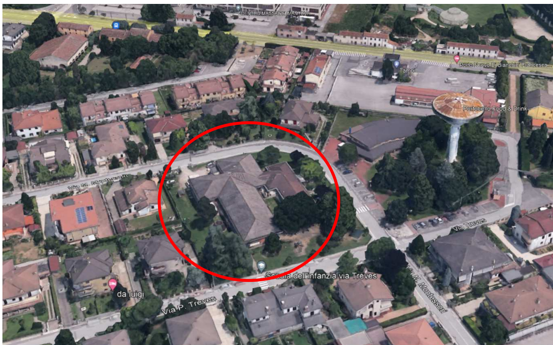
Vista aerea della sede staccata della scuola materna Treves
