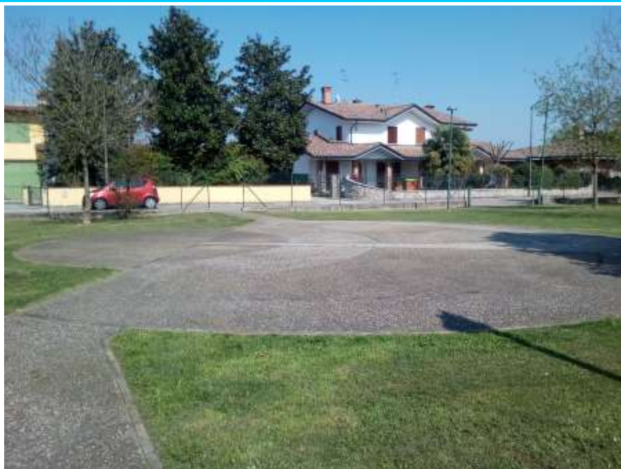
Pavimentazione esterna per esibizioni all'aperto
